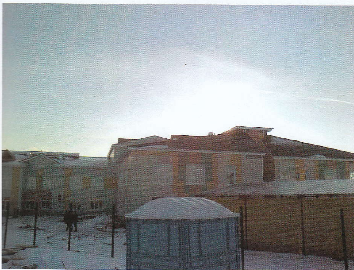
Рис.3 Фрагмент ограждающих конструкций здания снаружи
