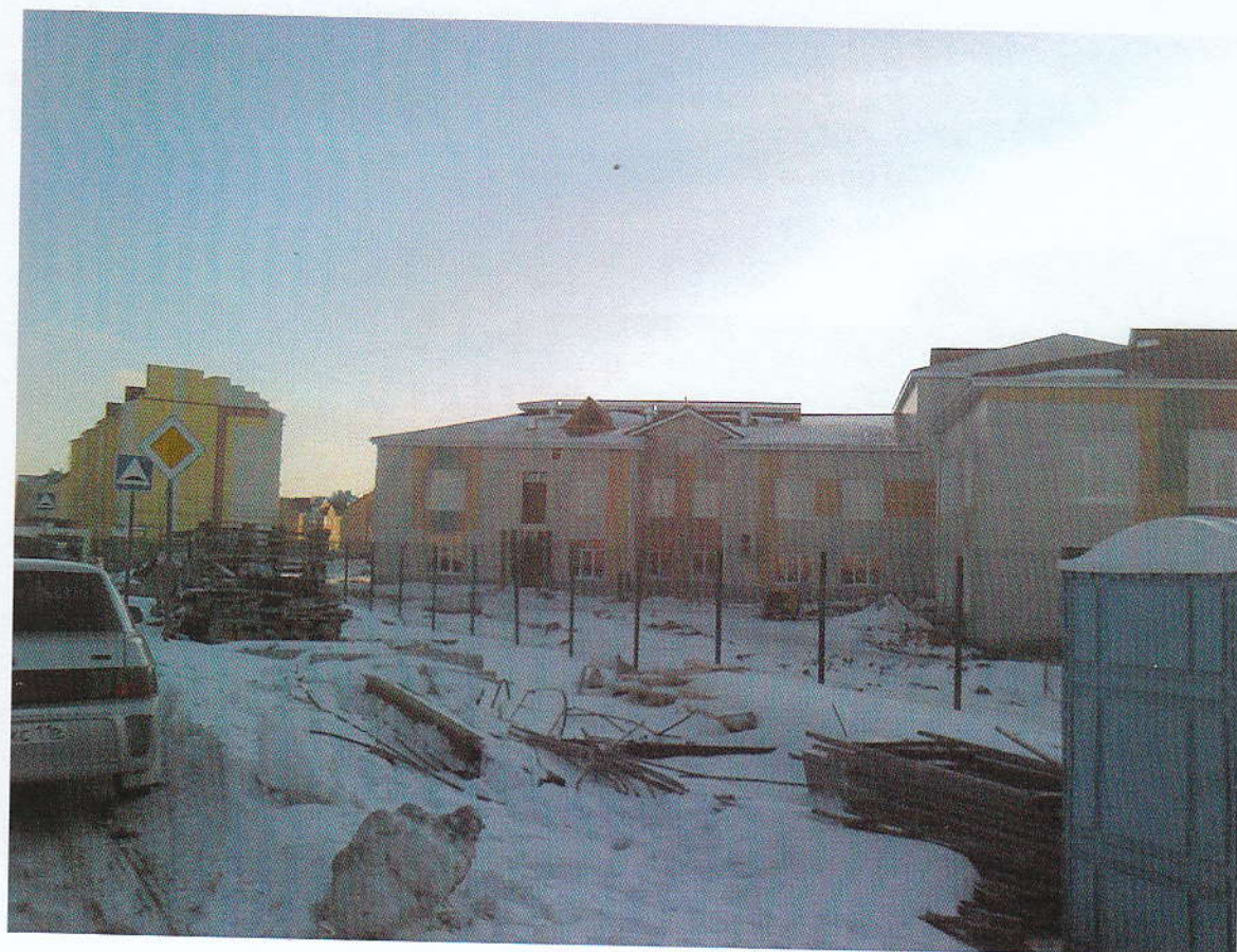
Рис. 1 Фрагмент ограждающих конструкций здания снаружи
