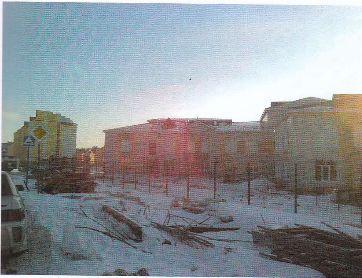
Рис. 2 Фрагмент ограждающих конструкций здания снаружи
